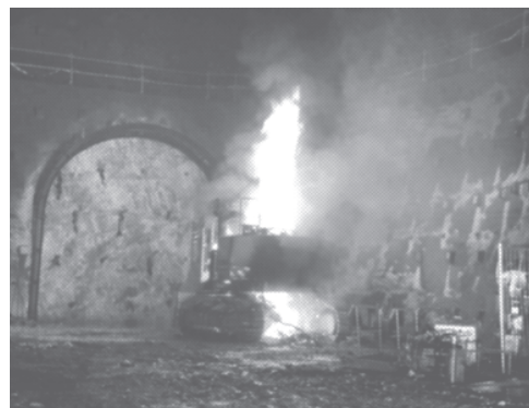
Feu sacré sur le chantier du TGV
